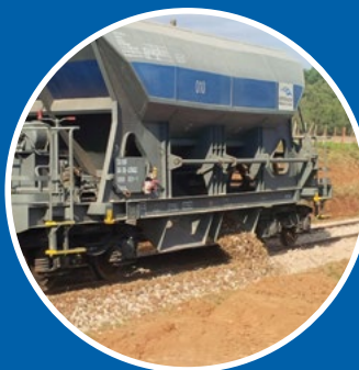
Trabajos de Vagón Tolva Pedrera (Fuente: UTF)
