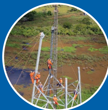
Montaje de torre en la Línea de Transmisión Margen Derecha – Estación Villa Hayes (Fuente: Itaipú)
